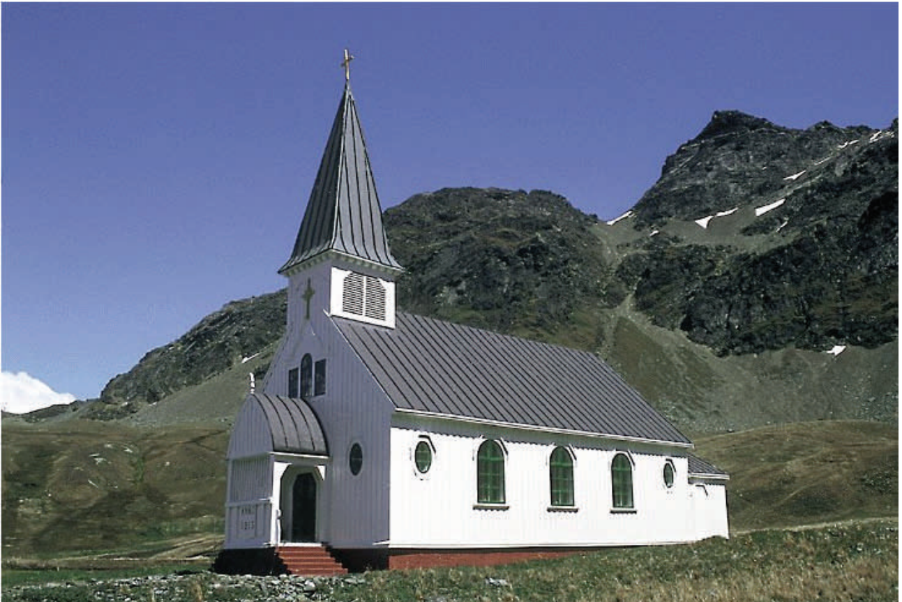
Die kleine Kirche in Grytviken wurde aufwändig restauriert.
